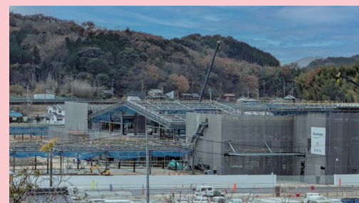
工事現場 令和6年12月
