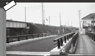
完成した三河橋(表川新町)
